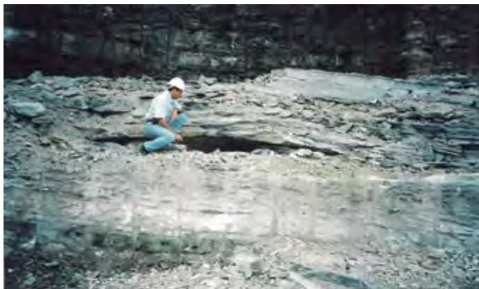
Figura 12 – UHE Candonga – Cavidade dômica associada com alívio de tensões, nas escavações do maciço gnáissico
