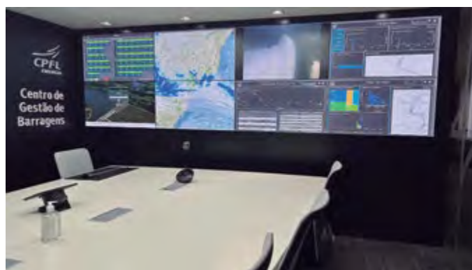
Figura 1 – Sala do Centro de Gestão de Barragens (CGB)
