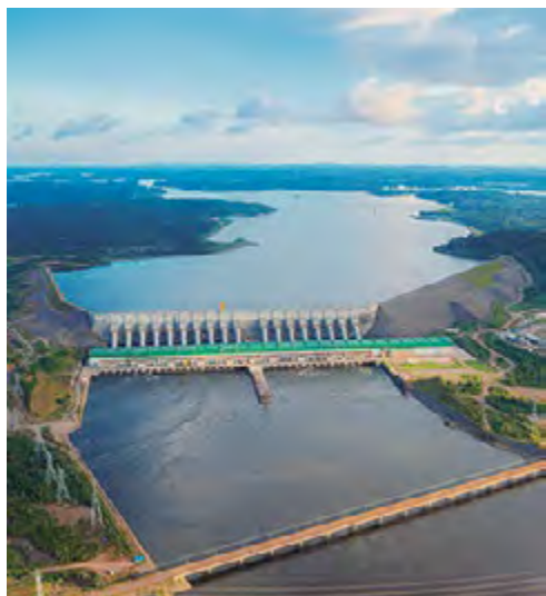
Usina Hidrelétrica Belo Monte Vitória do Xingu - Pará
