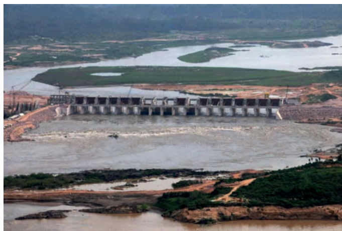
FIGURA 1 - Vista de jusante do vertedouro durante a construção
