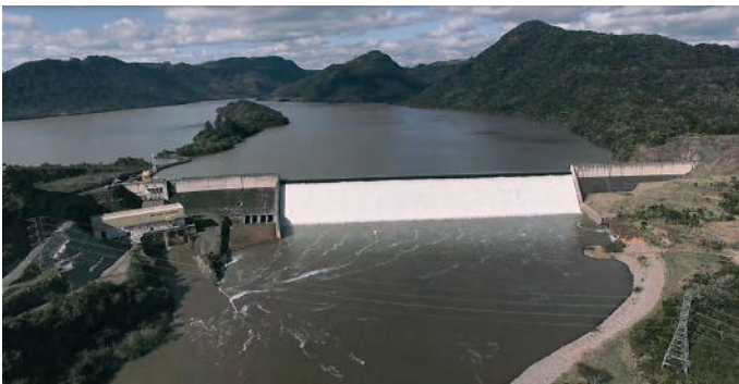
FIGURA 1 – Barragem Dona Francisca sem ponte na crista (DFESA)
