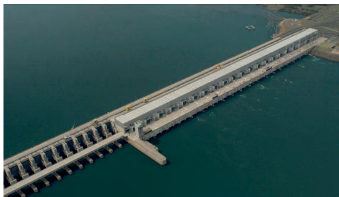
FIGURA 2 – Barragem Porto Primavera - ponte sobre vertedouro de superfície (José Caldas / CESP)
